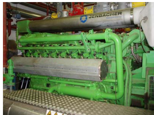
Abbildung 1: Fließbild eines Gasmotors zur kombinierten Produktion von elektrischem Strom und Wärme; Abbildung eines Gasmotors an der Biogasanlage Bruck/Leitha, Österreich (Quelle: Technische Universität Wien, Biogas Bruck GmbH)
